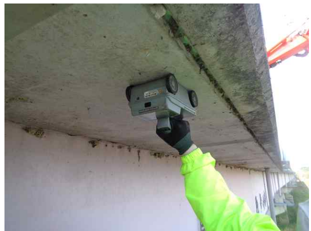
철근탐사 시험 - 피복깊이 측정
